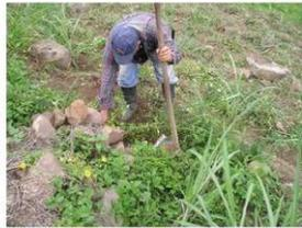
El desmonte es nada mas y nada menos que una limpieza del terreno, la cual se hace antes de empezar cualquier cosa, como las yerbas o malezas, en algunas ocasiones de ser necesario podemos cortar arboles, solo si se incluye en el proyecto. Por otra parte el despalde es la extracción de la capa superficial del terreno, para eliminar cualquier imperfección en nuestra superficie.
