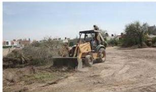
Esto depende de las condiciones en las que se encuentre el terreno, ya que podemos hacerlo antes o después del despalde y desmonte, consiste en remover material que puede estar suelto en la superficie.
