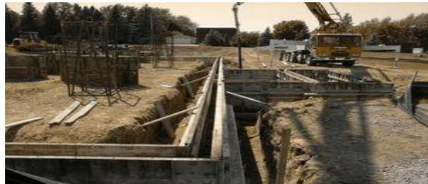
Las zapatas aisladas para la cimentación serán de hormigón armado para firmes superficiales o en masa para firmes algo más profundos, salvo las situadas en linderos y medianeras.
