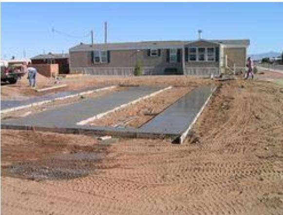
Los cimientos superficiales son aquellos que descansan en las capas superficiales del suelo y que son capaces de soportar la carga que recibe de la construcción por medio de la ampliación de base.
