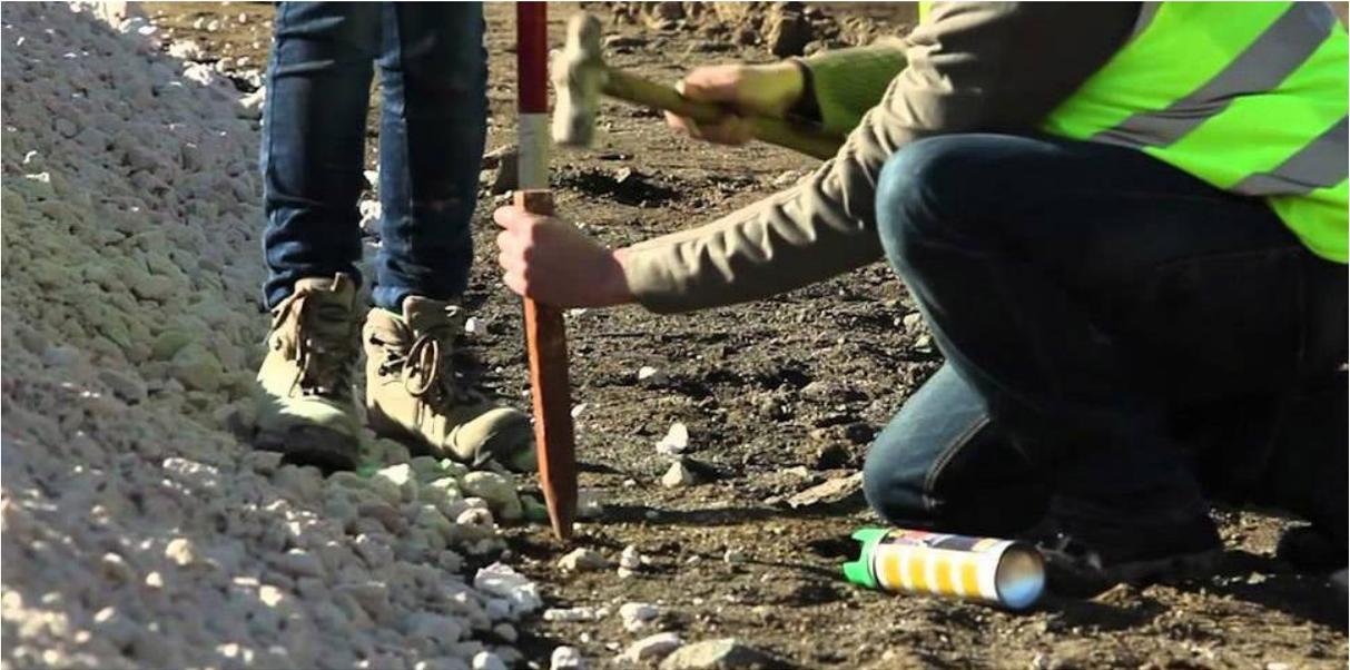
Se construirán bancos de nivel inamovibles e inalterables, que servirán como referencia y auxiliares para uso de los trabajadores en la construcción.
