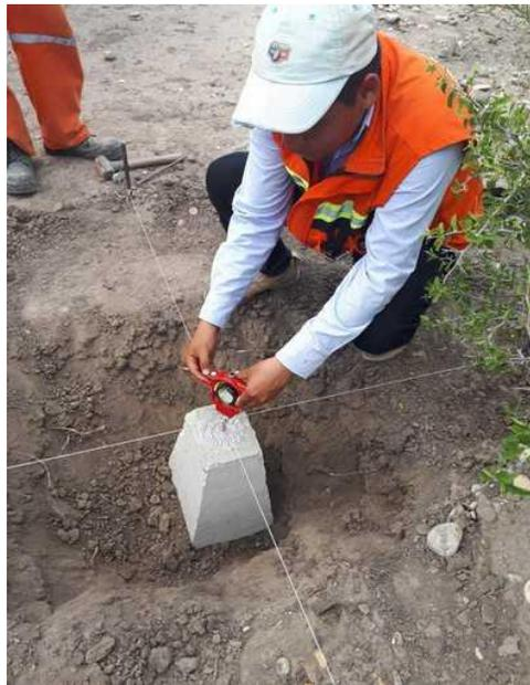
Se establecerán puntos de referencia de trazo para los puntos característicos del eje, marcándose sobre este mediante estacas.
