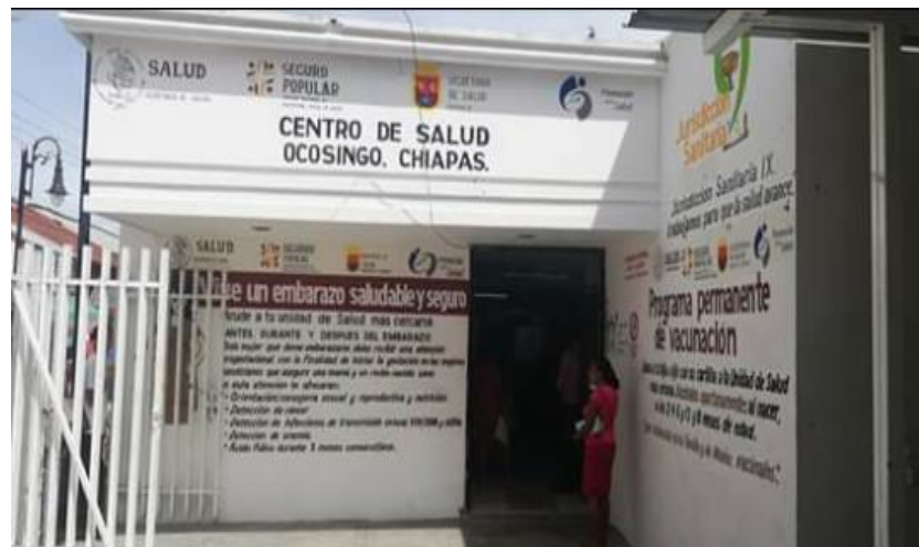
Imagen 2: Entrada principal del Centro de salud, Ocosingo, Chiapas. Fuente Google imágenes 2020.
