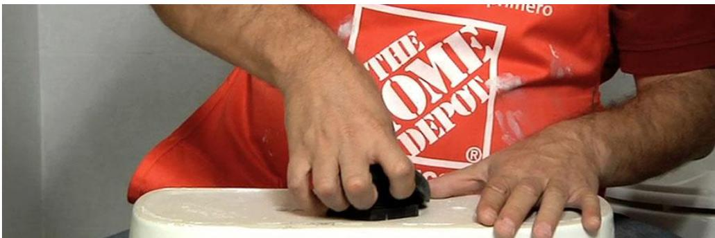
Voltea el tanque y colócalo sobre la taza del sanitario, centrando el empaque de hule en la abertura de la entrada del agua de la taza (cerca de su borde posterior).
