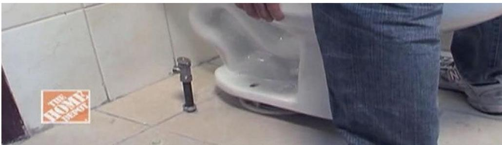
Presiona hacia abajo la taza del sanitario para comprimir el cuello de cera, de manera que selle herméticamente. Sujeta las rondanas y las tuercas a los tornillos del piso y apriétalos con una llave ajustable. No los aprietes demasiado, ¡la base se puede dañar! Después instala los tapones de los tornillos.
