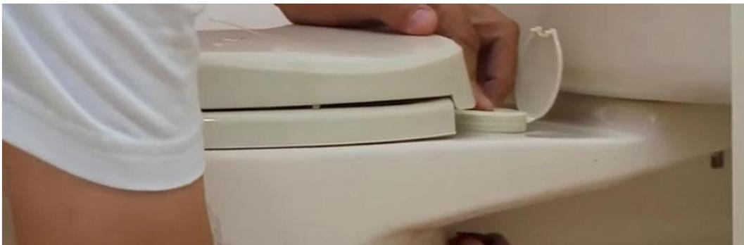
La última tarea es instalar el asiento del sanitario. Coloca los tornillos del asiento en las perforaciones del sanitario y ajusta las tuercas en estos mismos tornillos y listo acabas de instalar un sanitario.
