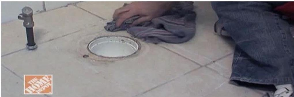
Asegúrate de que la base del sanitario esté limpia y que los tornillos del piso estén derechos. Si habías puesto un trapo en el agujero del drenaje para evitar los malos olores, retíralo. Coloca la masilla para plomería o silicón alrededor del contorno de la base del sanitario para sellarla al piso. Después coloca cuidadosamente el sanitario sobre su base y encaja las perforaciones de la base del sanitario directamente con los tornillos del piso.
