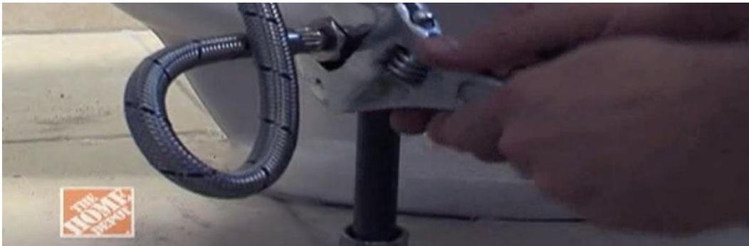
Corta un pedazo de tubo de suministro para conectar la llave de paso y el tanque del sanitario. Primero instala el tubo a la llave de paso y después a la llave del flotador de la taza. Aprieta las tuercas de conexión de las uniones con llaves ajustables hasta que queden bien sujetadas. Puede ser más fácil si sostienes la llave del flotador mientras aprietas la tuerca de conexión. Abre la llave de paso para llenar el tanque.
