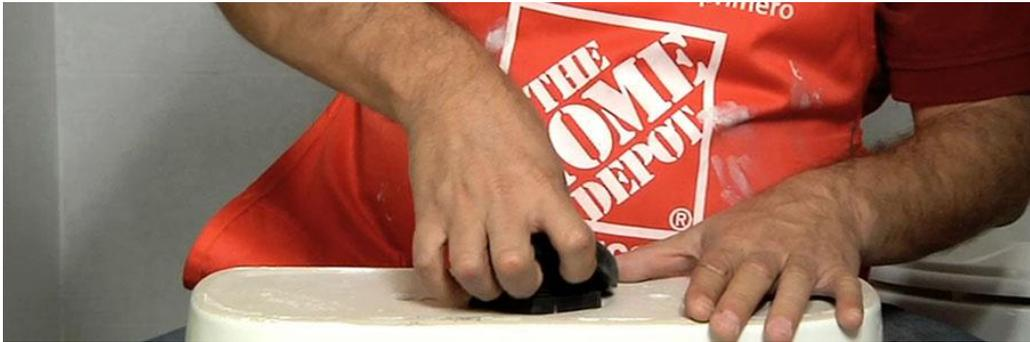
Ahora sigue con el tanque. En algunos casos, primero tendrás que instalar la palanca, la llave del flotador y la válvula de descarga. Coloca el tanque en posición invertida e instala el empaque de hule sobre la salida en la parte inferior del tanque.
