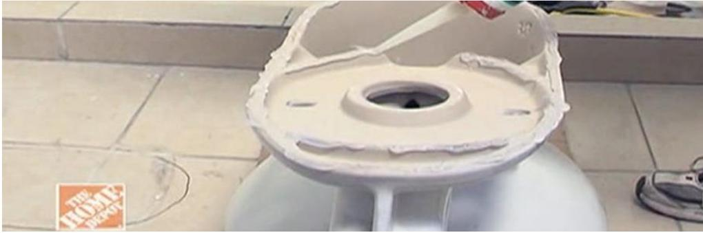
Para instalar un sanitario primero pon la taza nueva en posición invertida y coloca un cuello de cera nuevo alrededor de la tubería de salida del sanitario. Presiona hacia abajo firmemente para ajustar el cuello. Si el cuello tiene una cubierta de papel, quítasela.
