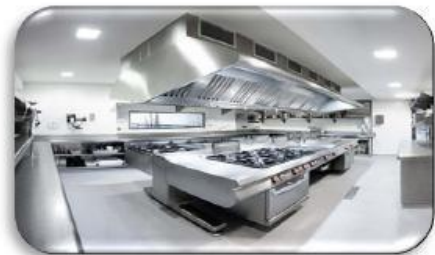
Campanas de extracción de acero inoxidable
