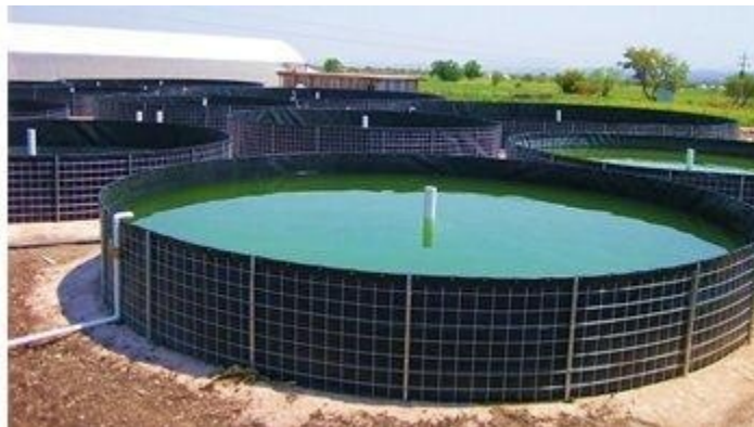
Tanque de oxigenación( foto abajo) y retorno con bombeo al tanque elevado
