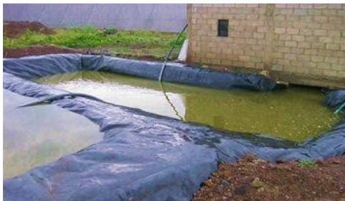
Tanque de oxigenación( foto abajo) y retorno con bombeo al tanque elevado
