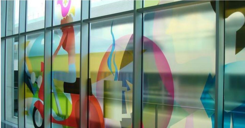
El vinilo transparente se realiza mediante diversos tipos de impresión digital mediante el uso de tintas ecosolventes y con protección ultravioleta, por lo que no se degrada ni se cuartea. Su inconveniente es que el resultado final de impresión generalmente muestra los colores en un tono mucho más apagado, por lo que es recomendable añadir una base blanca en donde se va a instalar para mostrar los colores tal cual como son.
