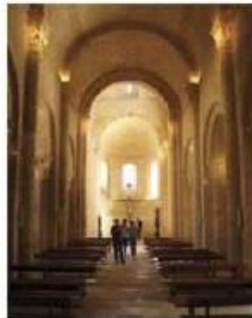
Bóveda acanfanada de piedra de la Iglesia de San Martín de Frómista, en Palencia.
