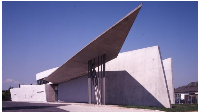
Estación de bomberos, Vitra, Alemania.
