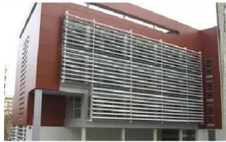
Fachada con Louver
