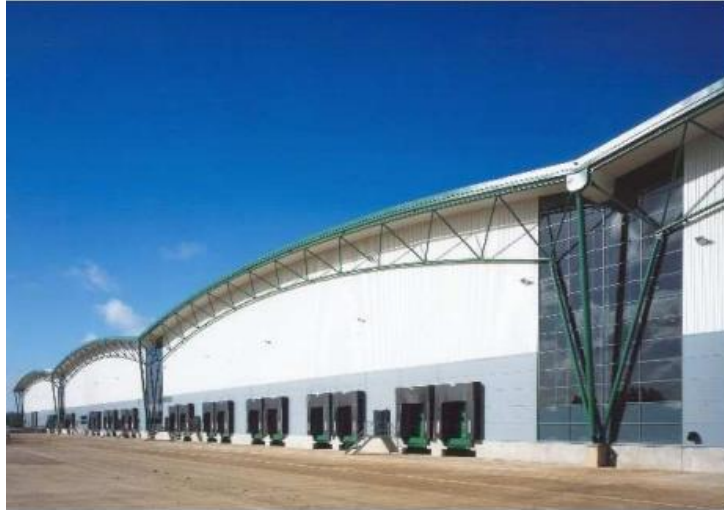
Figura 1.2 Nave de una sola planta con celosía en el exterior.
