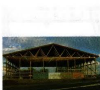
Fotografía 6.3 Las armaduras para techo, como las que se muestran en la foto, requieren apoyo sólo en los extremos. Gracias a esto es posible realizar construcciones con grandes áreas libres de obstáculos en el piso.
