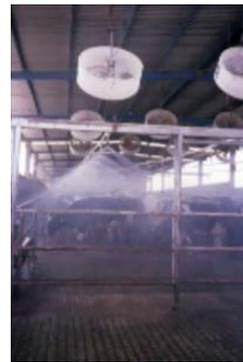
Apretadero y zona de espera, con diferentes diseños: arriba, apretadero tipo circular, con puerta giratoria; abajo, apretadero tipo rectangular con ventiladores aspersores, para eliminación de calor.
