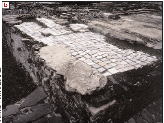
Piso de losas de caliza. Templo Mayor, etapa IVA.
