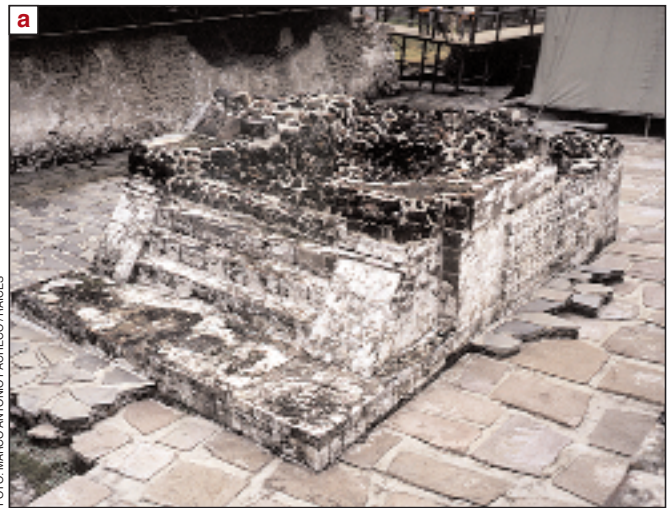
Plataforma, alfardas, escalinatas y fachadas revestidas con pequeños bloques de basalto; relleno de tezontle; pisos de andesita de lamprobolita y de andesita de piroxenos. Edificio B.
