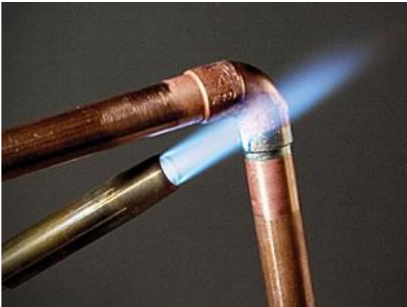
Soldadura de estaño – plomo, en proporción 50 – 50%
