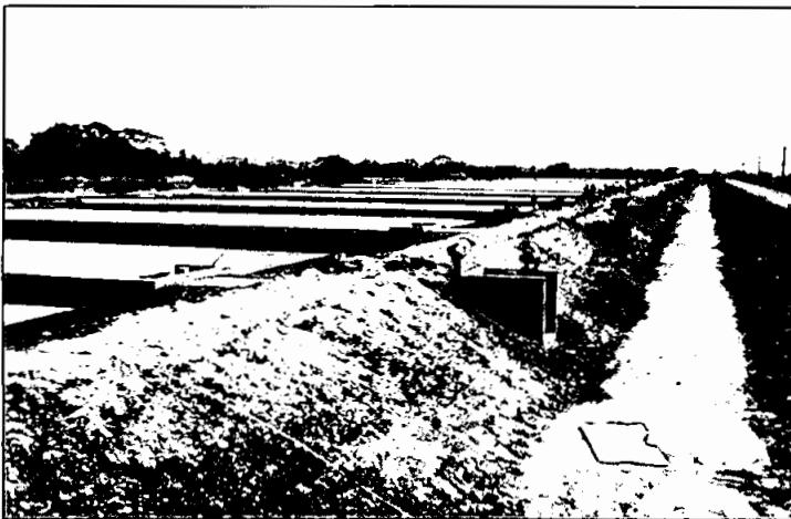
Figura 2.6. Un dique bajo construcción. A la izquierda se ve una serie de canales revestidos de concreto, cada uno de 500 m 2 de área, para el cultivo intensivo de peces.
