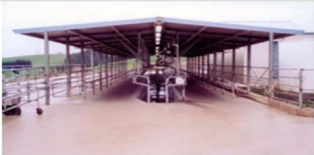
Modelo abierto de sala en espina, propio para trópicos.
