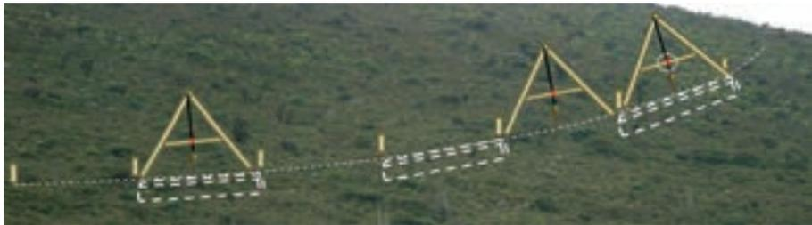
Figura 36. Marcación con aparato "A" para zanjas trinchera.
