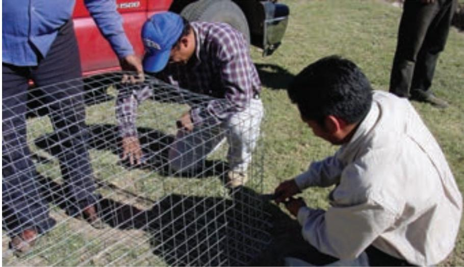
Foto 107. Armado de cajones con malla electrosoldada.
