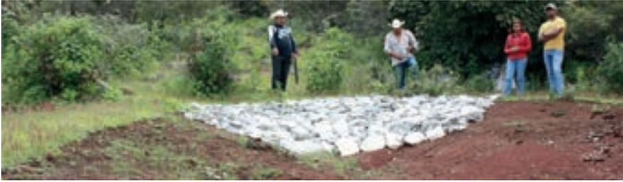
Foto 95. Control de la longitud de cárcavas
