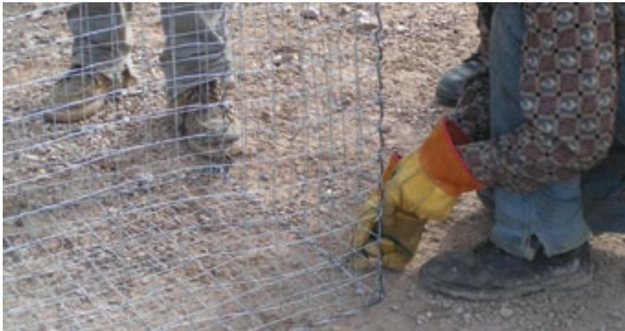
Foto 108. Unión de la malla con alambre galvanizado.
