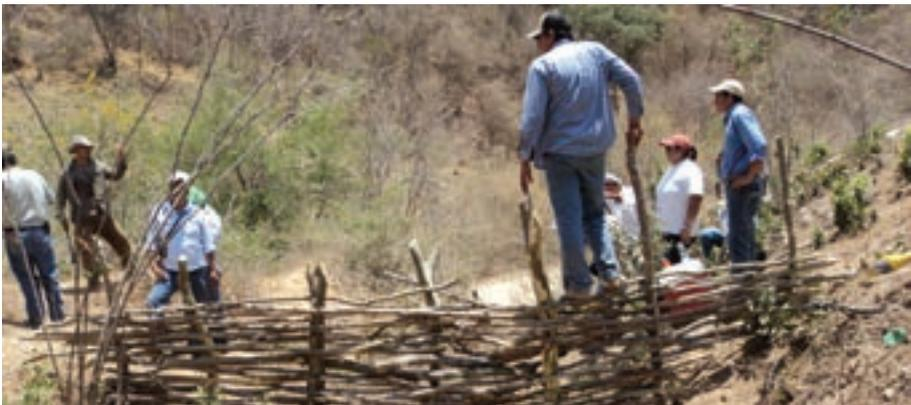
Foto 123. Presa de ramas tejidas, nótese la resistencia del tejido al aguantar el peso de una persona.
