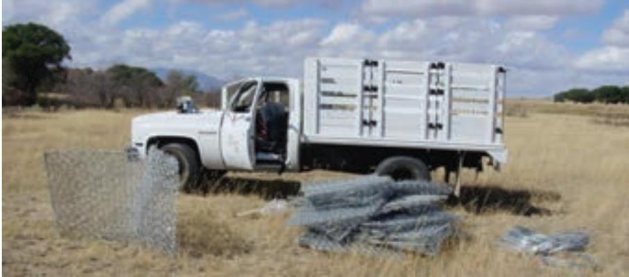
Foto 140. Desempacado y armado de gaviones.
