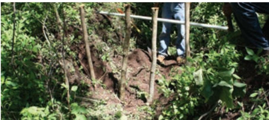
Foto 120. Colocación de postes para una presa de ramas.
