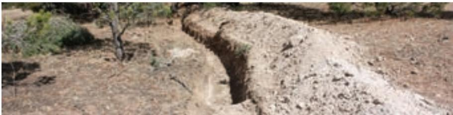
Foto 47. Zanja bordo construida en áreas con presencia de vegetación.
