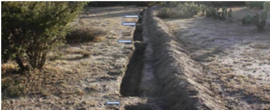
Figura 40. Diques en la zanja de una terraza de formación sucesiva.
