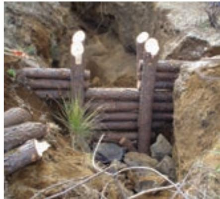
Foto 116. Vertedor en una presa de morillos.
