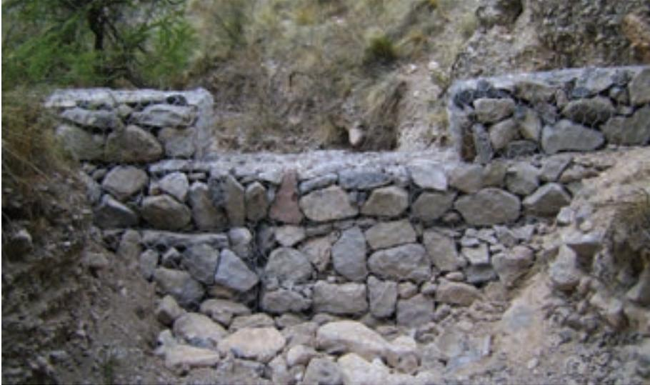
Foto 106. Presa de malla electrosoldada, con cabeceo de piedra.
