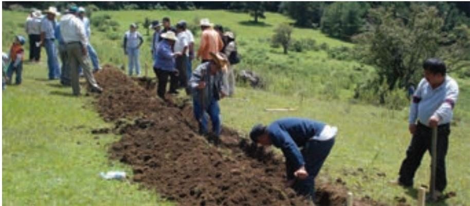
Foto 45. Construcción de obras tipo -zanja bordo-.
