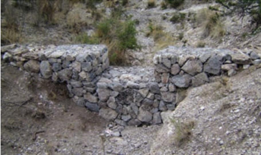
Foto 110. Vertedor de una presa de malla.
