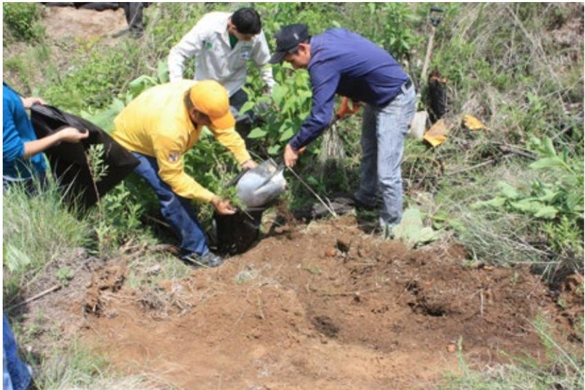
Foto 146. Llenado de geocostales con suelo producto de la excavación para el empotramiento.
