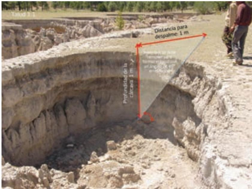
Figura 61. Despalmar de un talud con inclinación 1:1.
