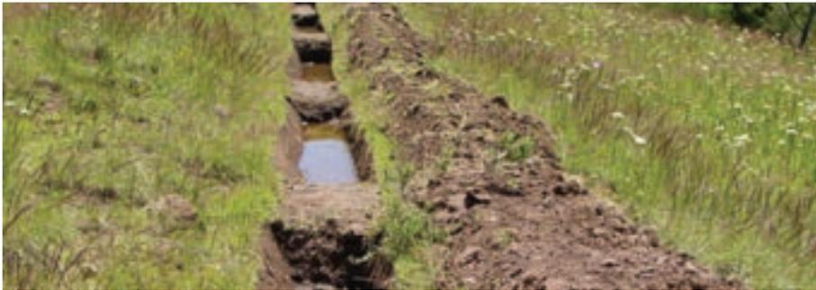
Foto 49. Diques divisores de la zanja bordo, al nivel de la superficie.
