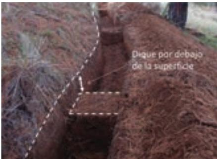
Figura 35. Diques de la zanja bordo, por debajo de la superficie.
