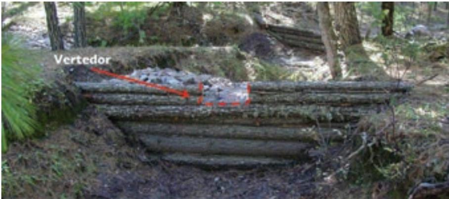
Figura 73. Vertedor de una presa de morillos.
