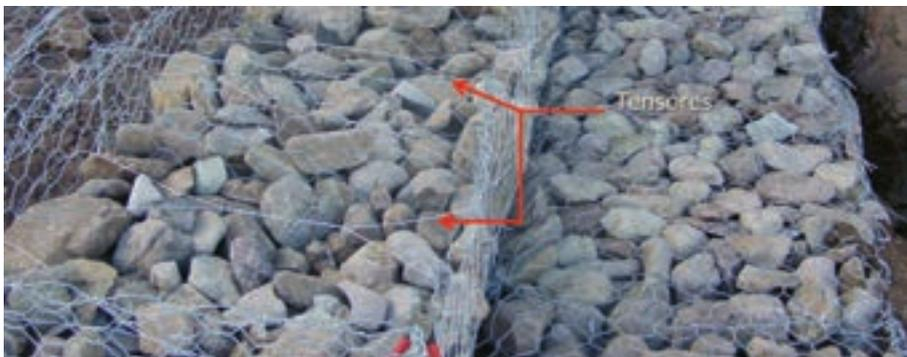
Figura 75. Instalación de tensores para evitar la deformación de los cajones.
