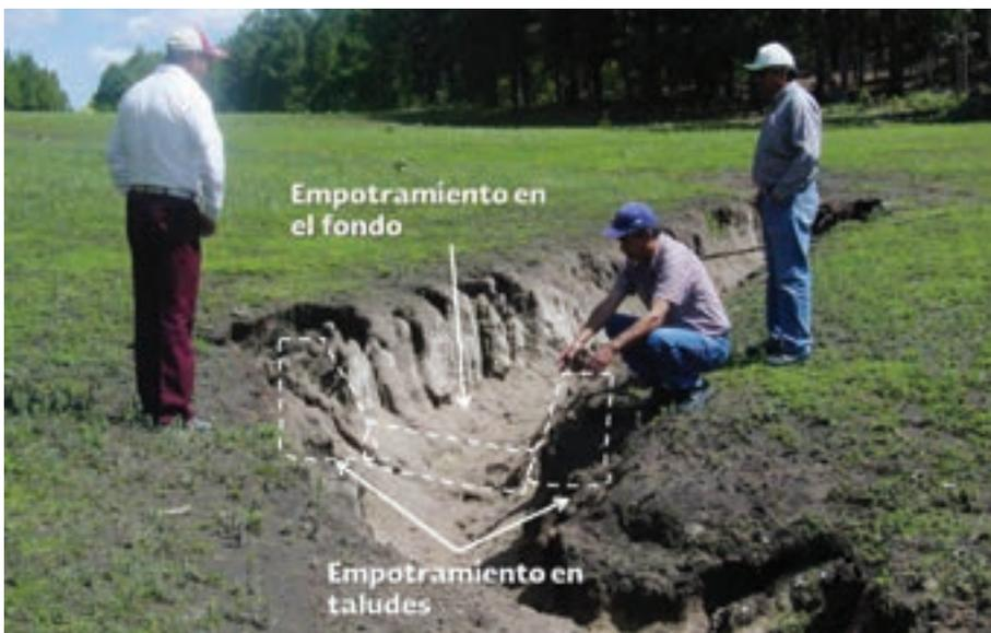
Figura 76. Zanja para empotramiento de una presa de ramas.
