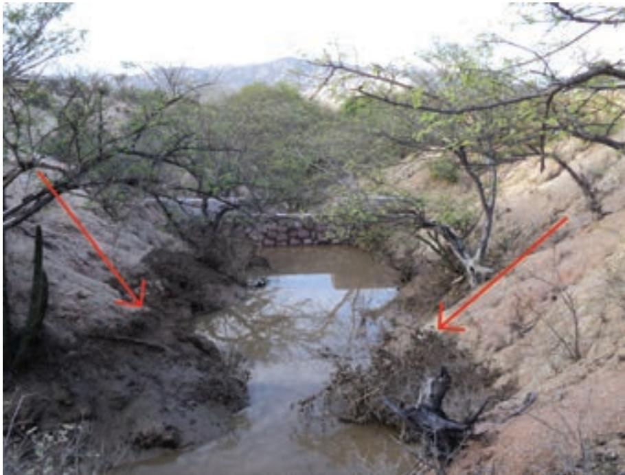
Figura 84. Presa de mampostería (Nótese la huella de almacenamiento del agua, lo que refleja el perfecto funcionamiento del vertedor).
