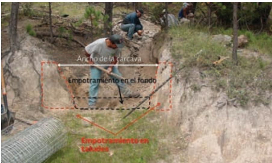
Figura 74. Excavación para empotramiento de una presa.
