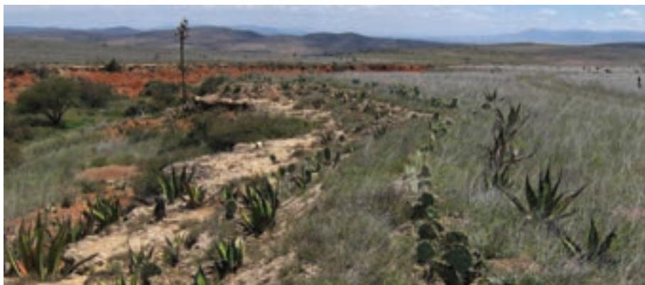
Foto 105. Estabilización de taludes con barreras vivas de maguey y nopal.
