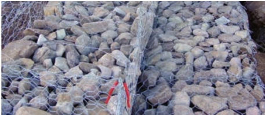
Foto 142. Colocación de tensores y cerrado de gaviones.
