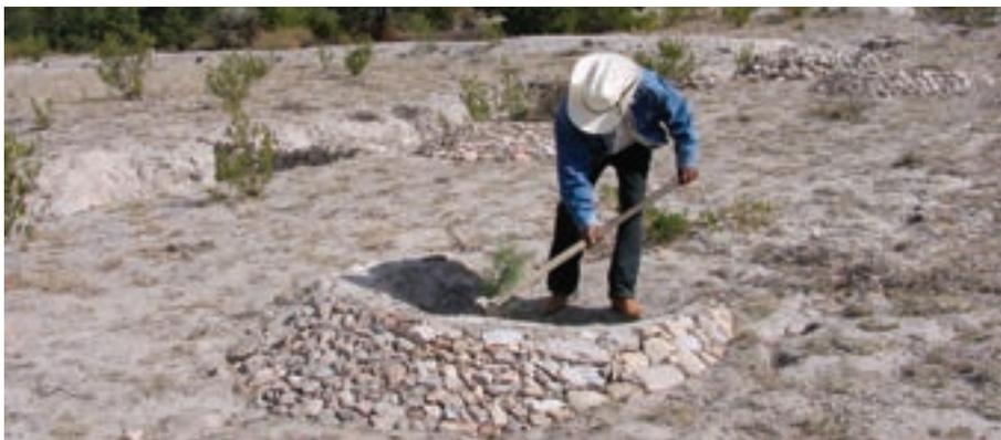
Foto 57. Terraza individual con taludes estabilizados.
