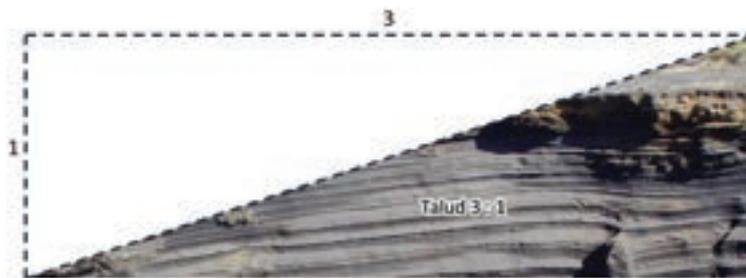
Figura 66. Talud con inclinación 3:1.
