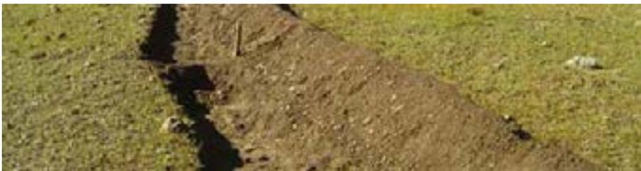
Foto 54. Zanja o canal de desagüe de la terraza de formación sucesiva.
