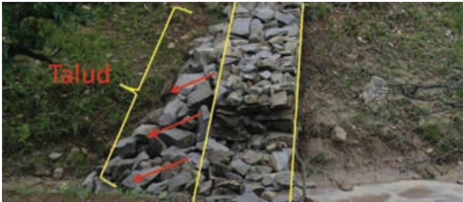
Figura 78. Presa de piedra con un talud aguas abajo.
