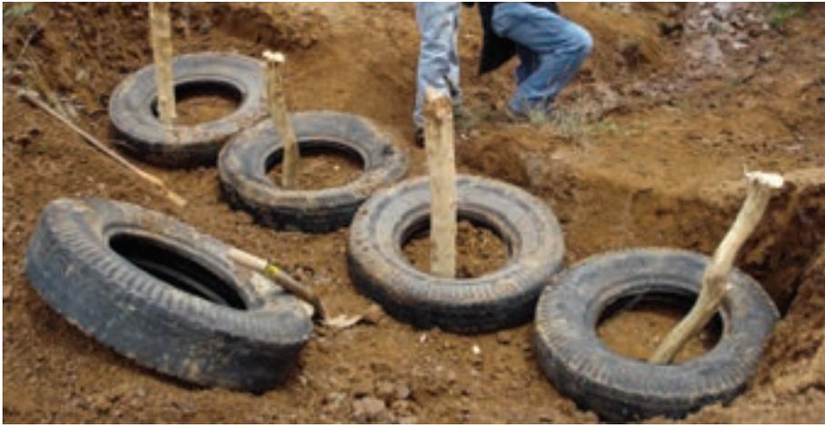
Foto 132. Empotramiento para la construcción de una presa de llantas.
