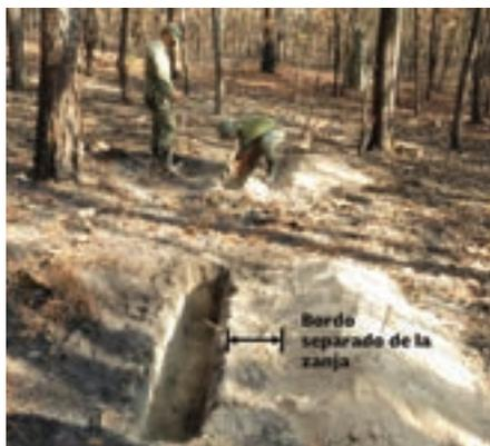
Figura 38. Separación del bordo con la zanja y compactación del mismo.
