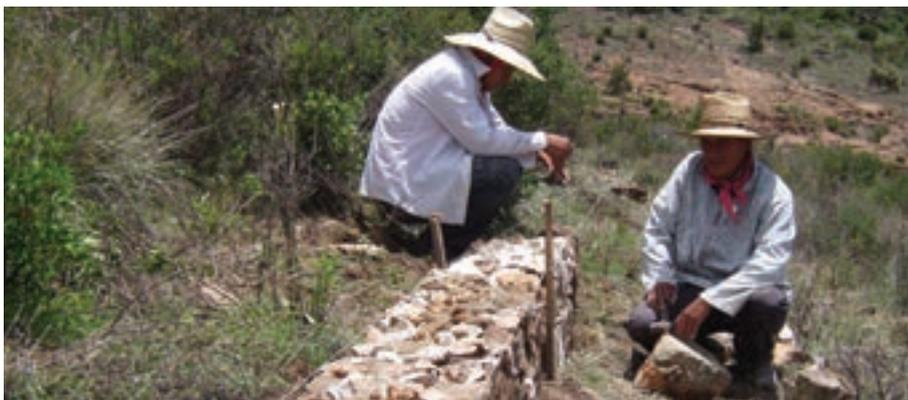
Foto 71. Uso de hilos para conformar la barrera.
