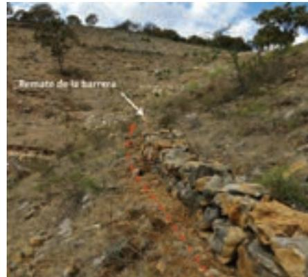
Figura 45. Barreras de piedra terminadas antes del cambio de la pendiente.
