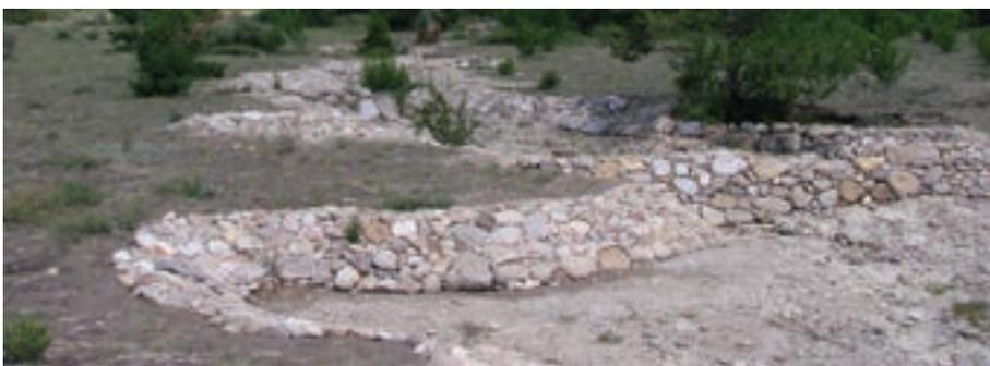
Foto 102. Estabilización de taludes mediante zampeado seco de piedra.
