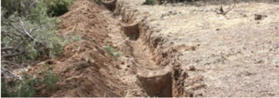
Foto 48. Zanja bordo, con el bordo separado de la zanja.
