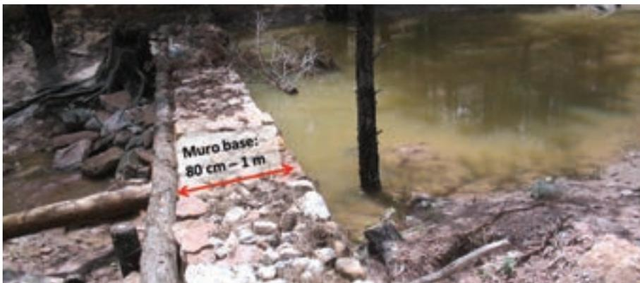
Figura 77. Muro base de una presa de piedra.
