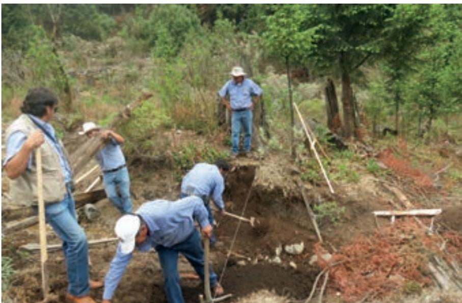
Foto 113. Empotramiento para una presa de morillos.
