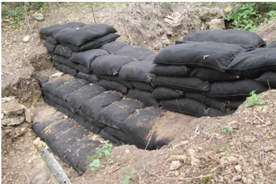
Foto 147. Presa de geocostales con vertedor.
