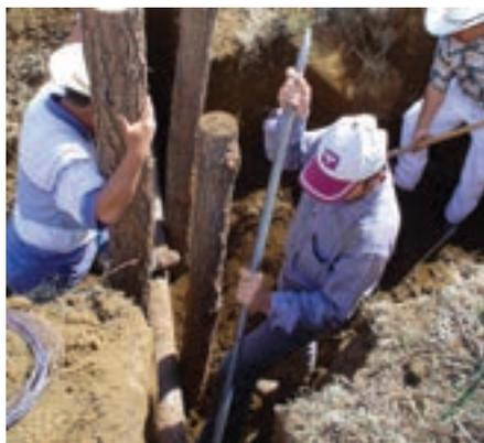
Foto 114. Colocación de postes en una presa de morillos.
