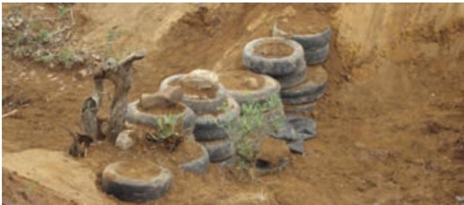
Foto 134. Formación del vertedor en una presa de llantas.
