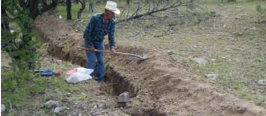
Foto 55. Conformación y compactación del bordo.
