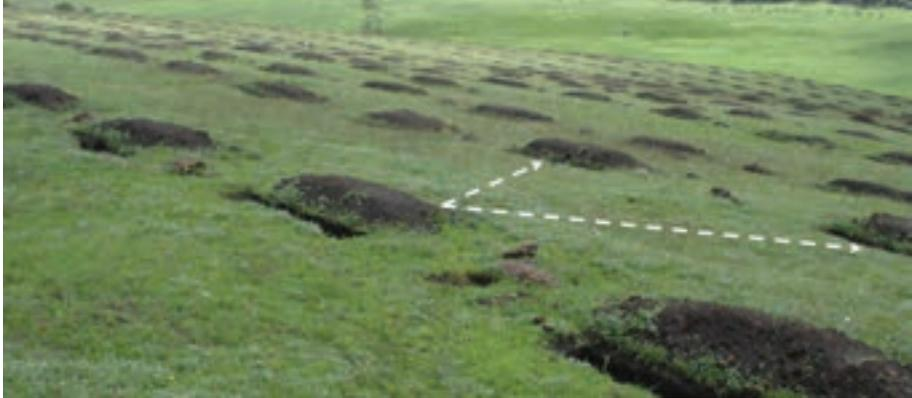
Figura 39. Arreglo en “tresbolillo” de zanjas trinchera.
