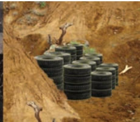
Figura 81. Vista lateral de la formación de la presa con tres hileras de llantas para su estabilidad.
