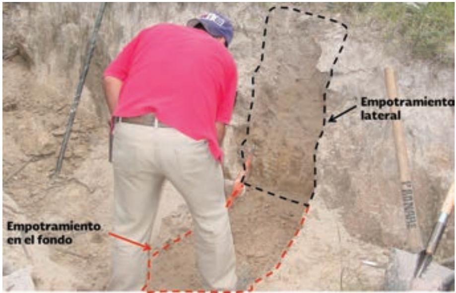
Figura 72. Empotramiento de una presa en el fondo y las paredes de una cárcava.
