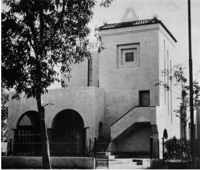
3. Fachada norte - Entrada principal
