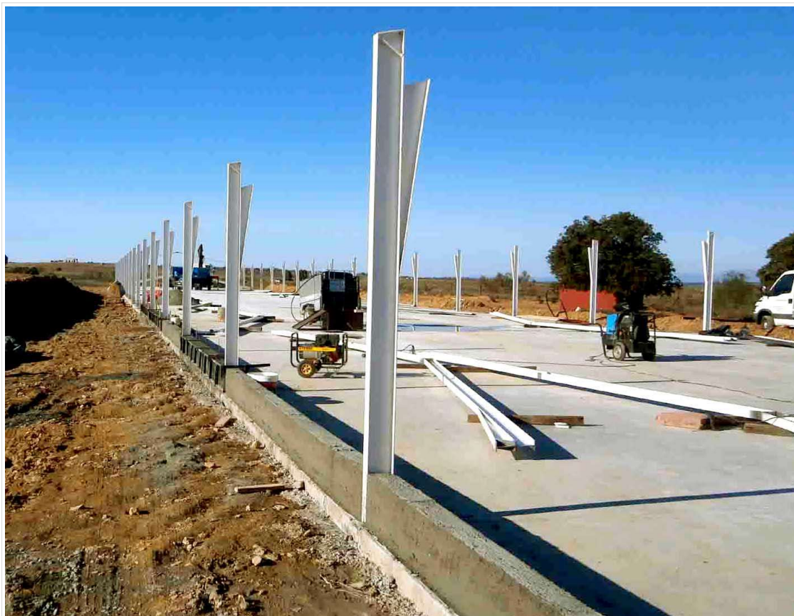
Nave avícola en construcción (granjas-de-pollos.php)
