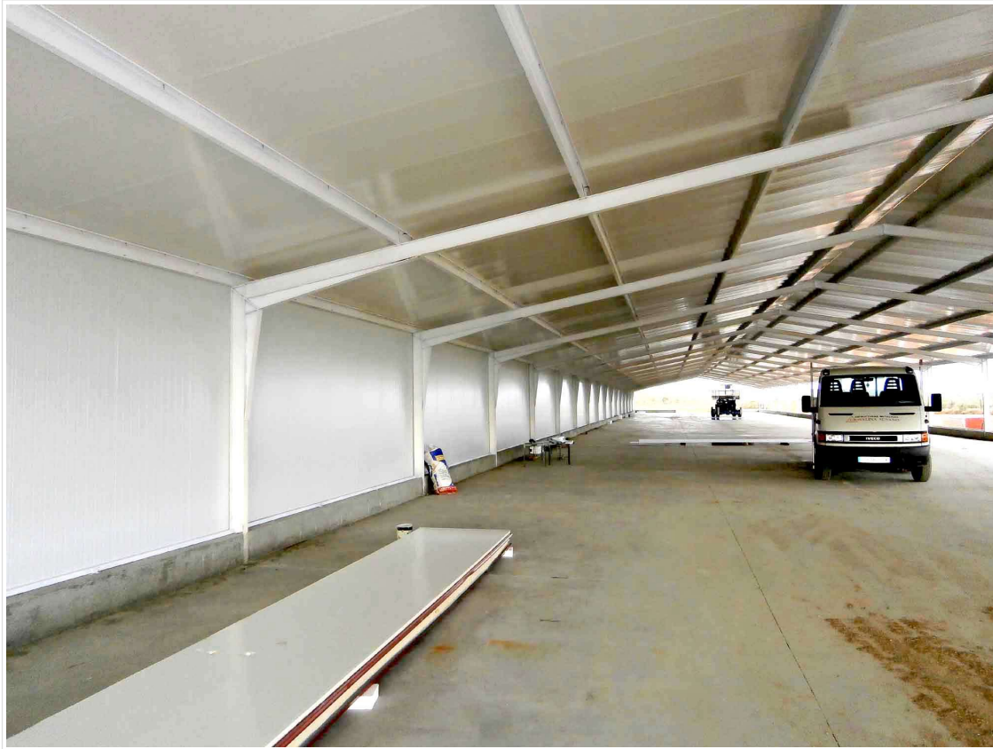
Interior de nave avícola (granja-avicola.php)
