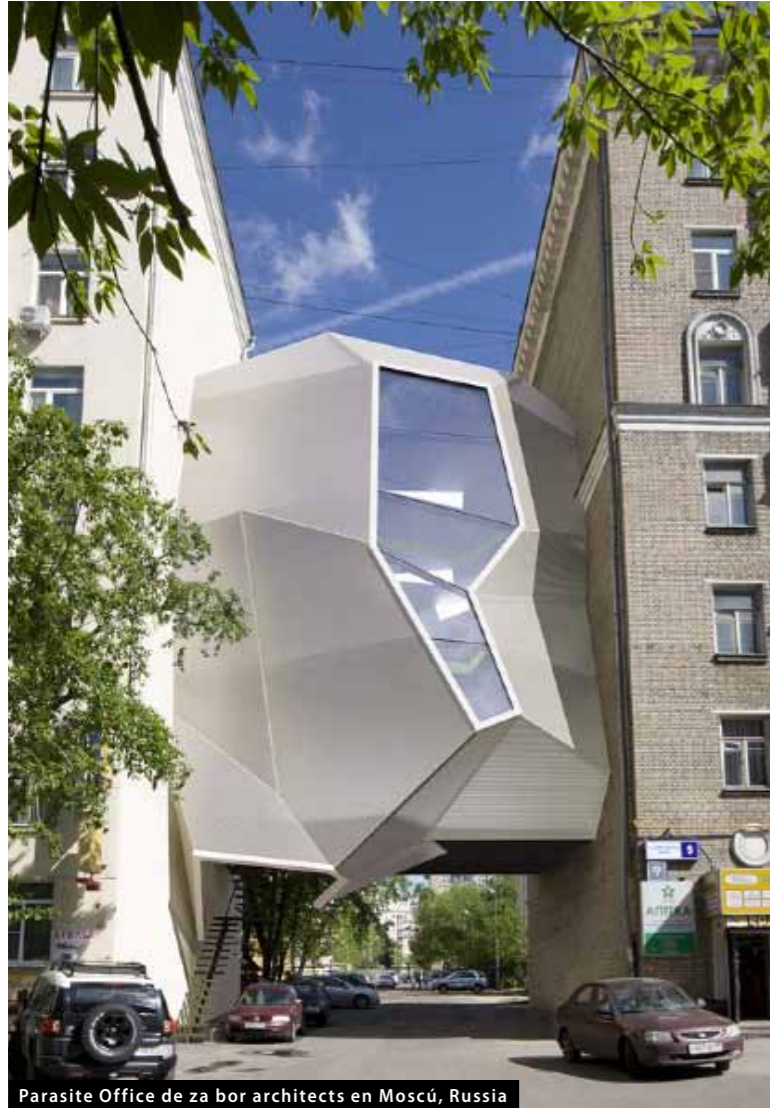
Parasite Office de za bor architects en Moscú, Russia
