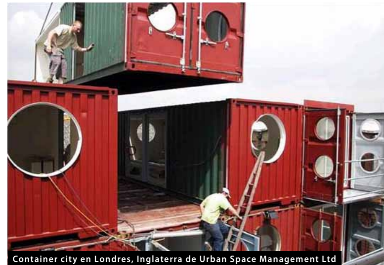
Container city en Londres, Inglaterra de Urban Space Management Ltd
