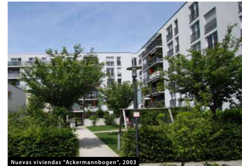
Nuevas viviendas „Ackermannbogen“, 2003
