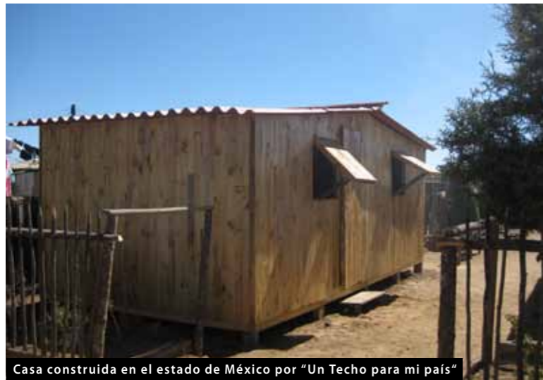
Casa construida en el estado de México por "Un Techo para mi país"
