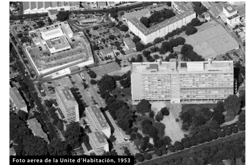
Foto aerea de la Unite d'Habitación, 1953
