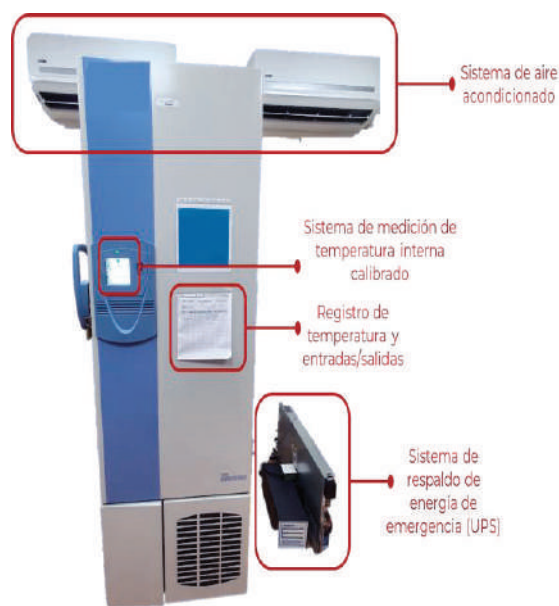
Figura 4.4. Elementos básicos de instalación de un ultracongelador.
