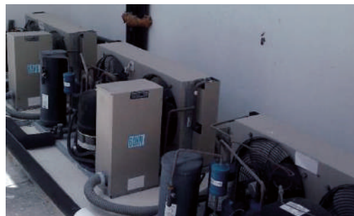
Fotografía 4.4. Unidad condensadora.
