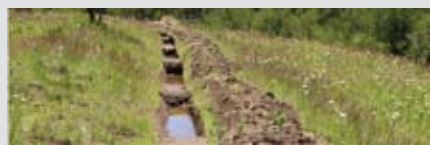
Zanja trinchera (tinas ciegas)
