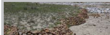
Estabilización de taludes
