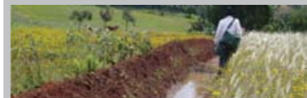
Zanjas derivadoras de escorrentía
