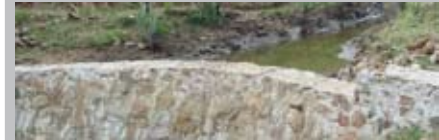
Presas de mampostería
