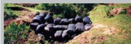
Presas de geocostales
