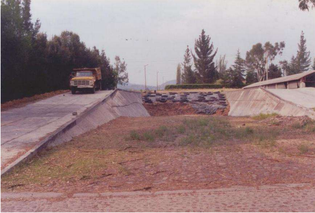
Figura 14. Almacén de forrajes. Silo de trinchera, con rampa de llenado. Romero, MJ. 2002.
