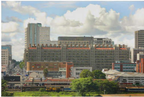
Figura 5: En la ciudad de Harare en Zimbabue se encuentra el más grande complejo de oficinas y comercios de este país, el East Gate Centre. Su construcción sigue los principios de climatización usado por las termitas para garantizar que el edificio mantenga una temperatura agradable todo el tiempo de manera pasiva, sin el uso de costosos equipos de aire acondicionado o calefacción. [CC Share Alike. Foto de David Brazier]
