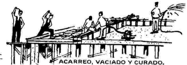
ACARREO, VACIADO Y CURADO.
