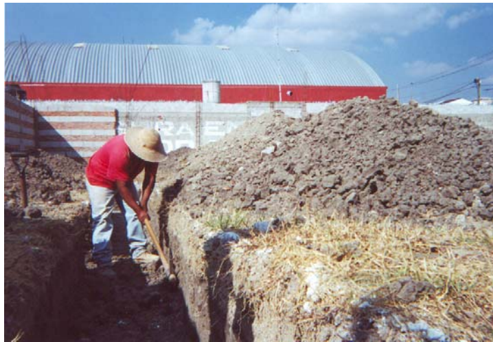
Excavación de las cepas a mano, utilizando pala y pico.
