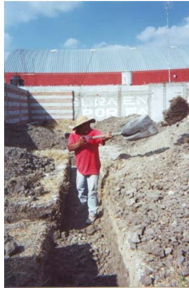
Excavación en cimentación.
