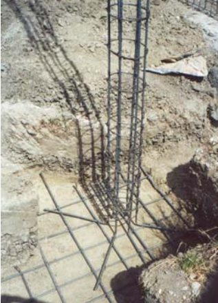
Armado de la base de la zapata y un castillo.
