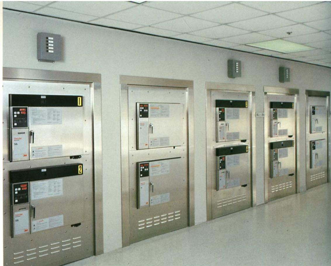
**Esterilizadores/aireadores de gas de Óxido de Etileno. El ciclo de aireación se inicia de forma automática después de la esterilización. Los parámetros humedad, temperatura y vacío de la cámara se registran en una impresora incorporada y pueden controlarse en todo momento. Al inicio de la esterilización el operador programa el ciclo adecuado.**
