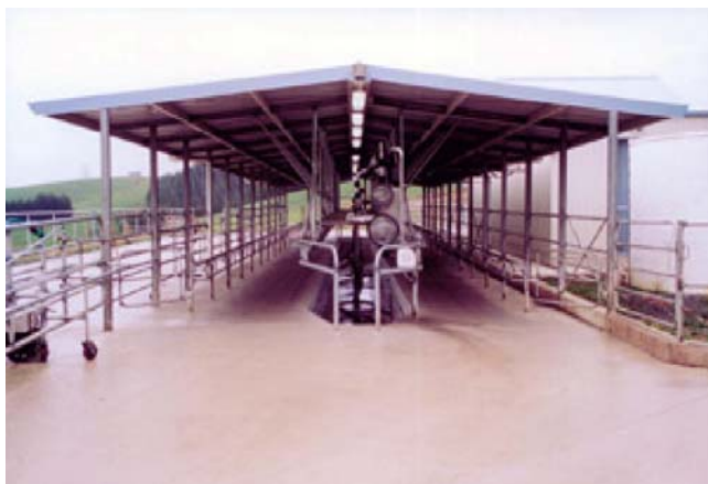
Modelo abierto de sala en espina, propio para trópicos.
