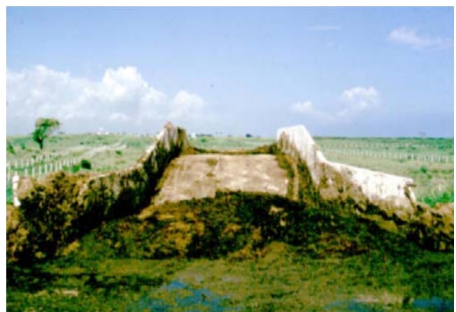
Estercolero con rampa para evacuación.
