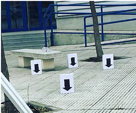
Figura 20. Ejemplos de replanteo de zapatas. Método de replanteo por coordenadas polares con una estación total.
