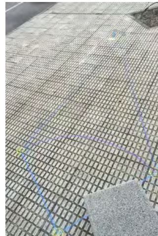
Figura 20. Ejemplos de replanteo de zapatas. Método de replanteo por coordenadas polares con una estación total.
