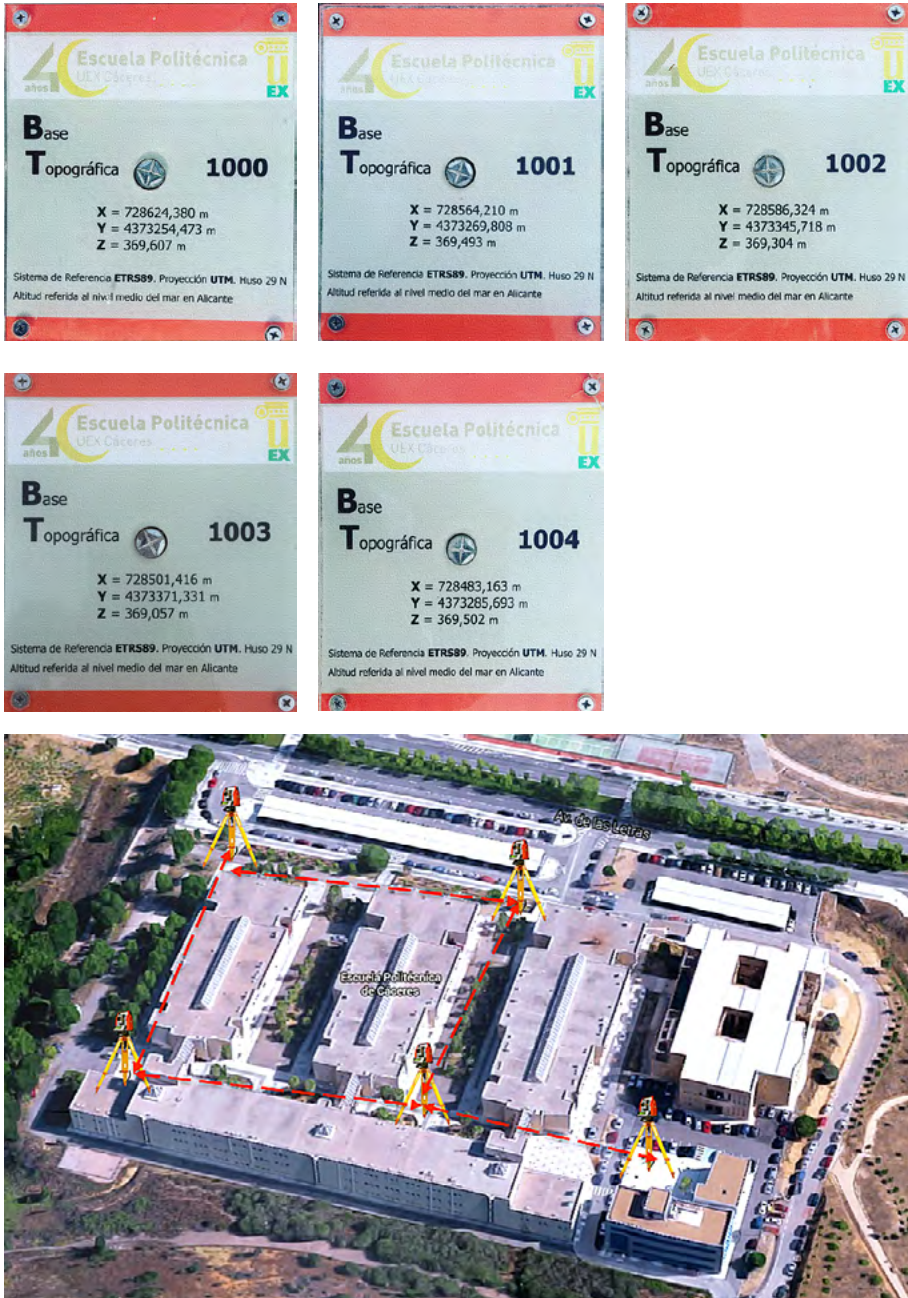
Figura 23. Imagen de situación de las placas Bases Topográficas de la Escuela Politécnica. (fuente: Aurora Cuarteo y Manuel Guerrero. Toma de datos realizada con GNSS en la 40th Semana Cultural de Politécnica, mayo de 2014. Imagen de fondo obtenida en Google Map). En el anexo 3 se incluyen las reseñas de estas bases topográficas.
