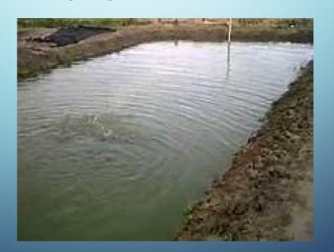
Con respecto a la inclinación de los taludes debemos tomar una relación de 3:1 en la cara interna y 2:1 en la cara externa. El ancho de la cresta debe ser lo suficiente como para que transiten las máquinas o vehículos. La altura del dique va a depender de los estudios hidrológicos y del volumen de agua necesario que requiera el proyecto en épocas de sequía
